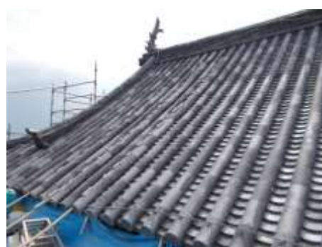
3 丸瓦葺直し完了
