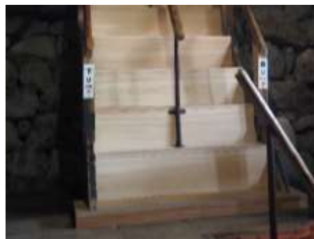
3 踏板補強完了
