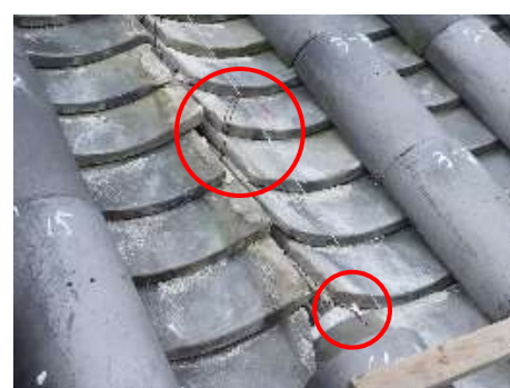
2 丸瓦固定用銅線設置
