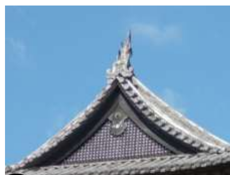
2 4階妻壁塗直し完了
