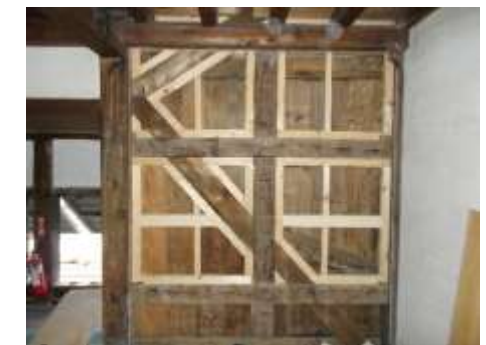
3 下地枳材(檜材)取付け
