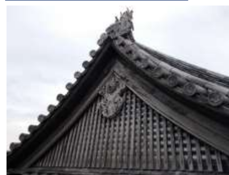
1 4階妻壁塗直し前
