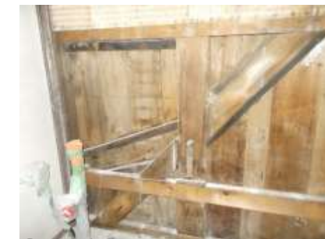
2 縦板(昭和の檜材)撤去
