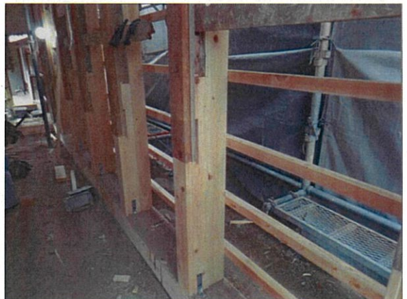
ジャッキダウン、壁下地取付状況
