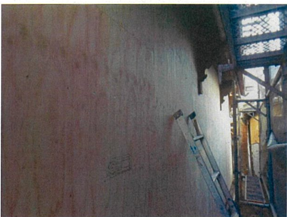
壁下地貼状況
