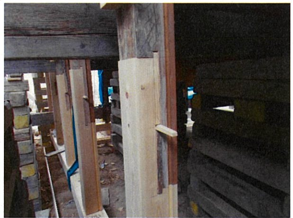
ジャッキアップ後土台、柱差替状況
