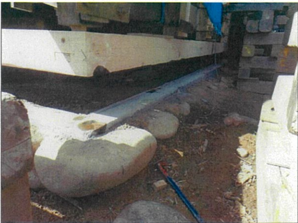
土台下レベルモルタル施工状況
