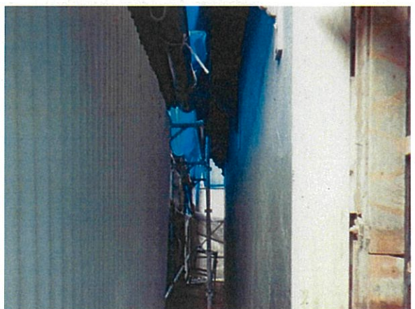
ラス網張りの上漆喰塗状況
