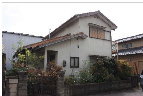
敷地内に草木が繁茂し隣地や道路に越境
