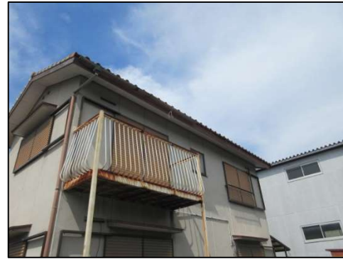
雨樋が固定された
