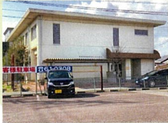
犬山南地区学習等供用施設
