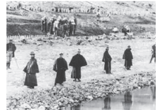
▲明治16年の入鹿池改修工事（入鹿池史より）
