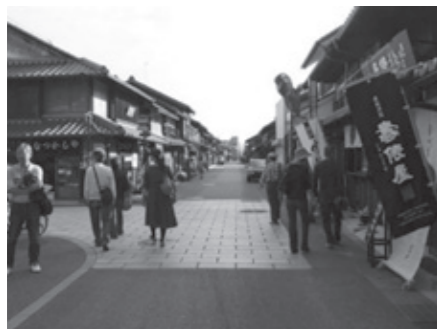
▲電柱の地中化・道路の美装化後（本町）
