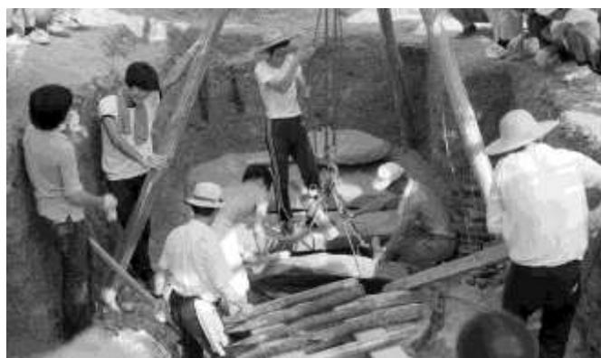
写真 4-7 天井石移動作業 (昭和 48 年)
