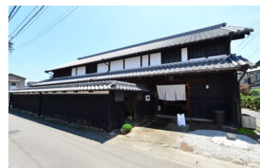
旧堀部家住宅
