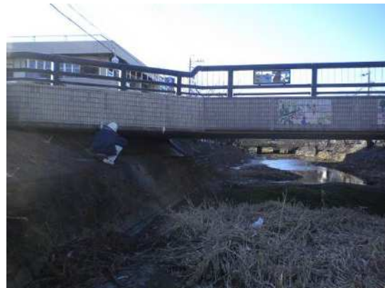
写真-1.5 職員による点検状況②
