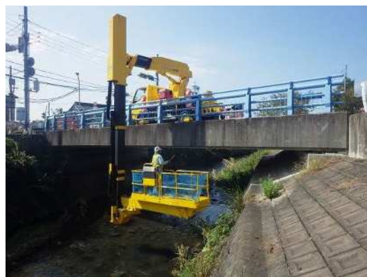
写真-1.3 専門業者による点検状況②
