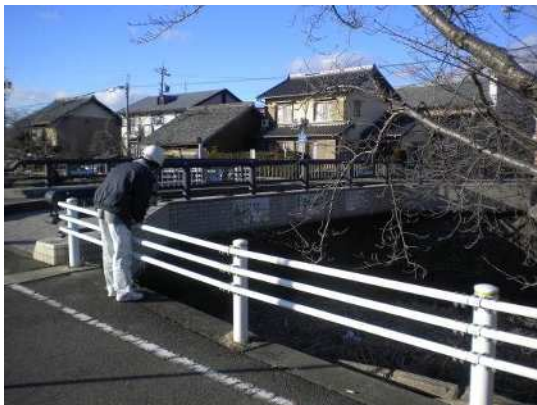
写真-1.4 職員による点検状況①
