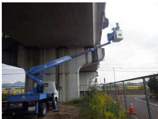
写真-1.2 専門業者による点検状況①
