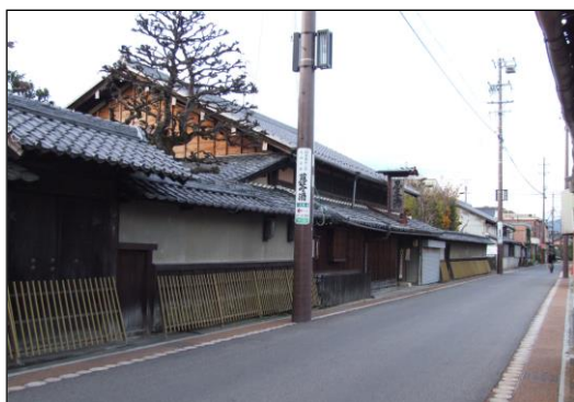
城下町ゾーン内の道路
