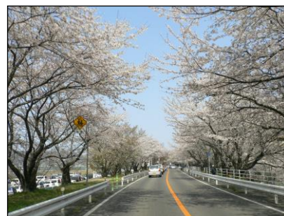
木曽川の堤防（御囲い堤）
