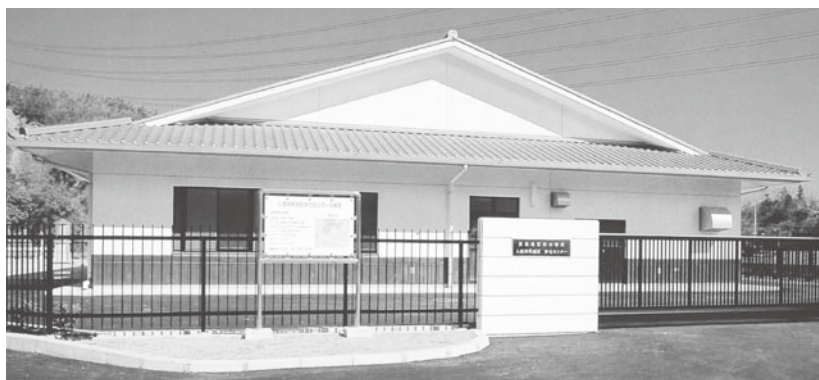
入鹿神尾地区浄化センター
