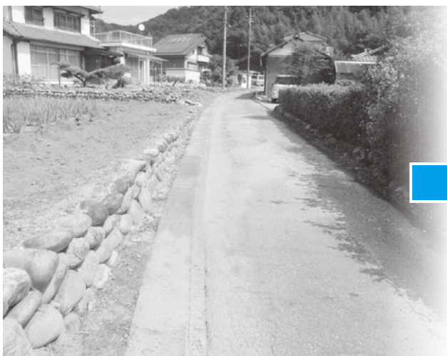
拡幅工事施工前
