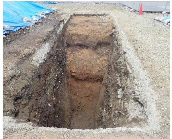
2トレンチ堀斜面（南から）
