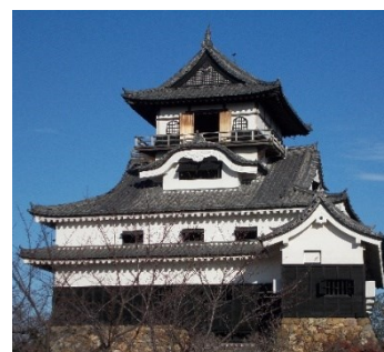
犬山城天守保存修理工事の様子
