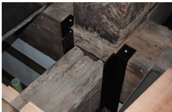
図5.17 梁仕口補強 金物取付状況
