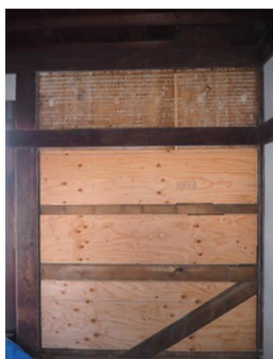
図5.20 壁補強 合板取付
