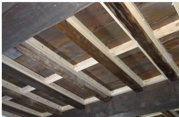
図5.15 水平構面補強、枋材固定状況
