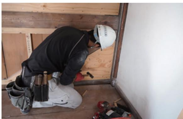
図5.19 壁補強 合板取付状況
