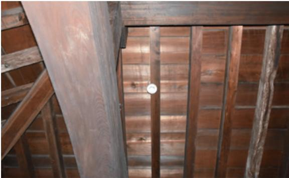
図 5.11 二階煙感知器の設置位置に工夫が必要
