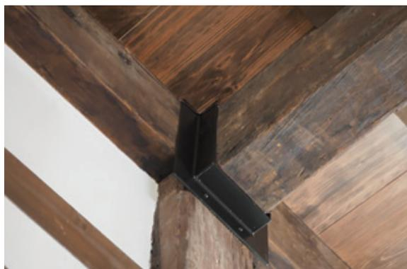
図5.18 梁仕口補強 金物取付状況
