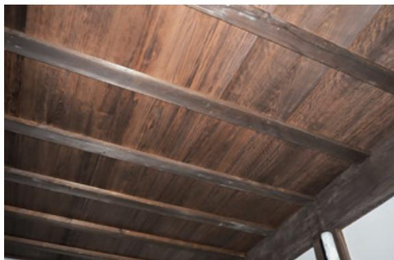
図5.16 水平構面補強、化粧板古色塗完了
