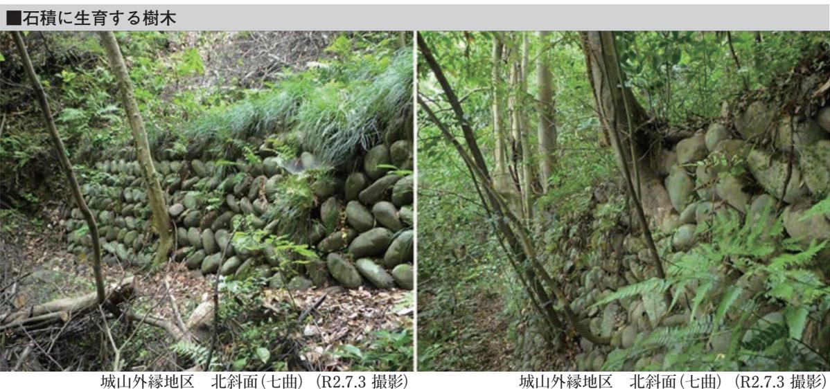
図 4.49 斜面の安定施設を損傷する恐れのある樹木(「犬山城樹木調査(令和2年度)」より抜粋)
