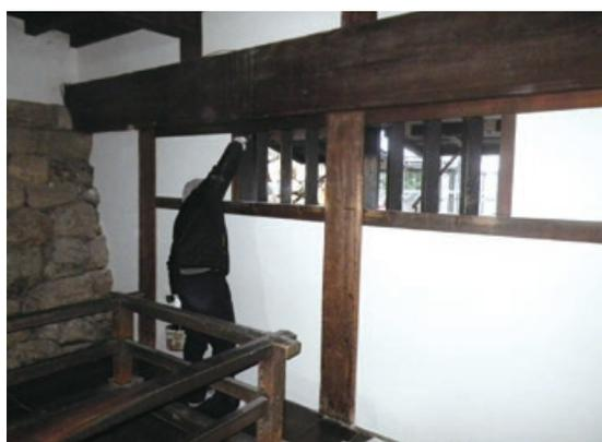
図4.42 建具枠と格子の塗装塗り直し
