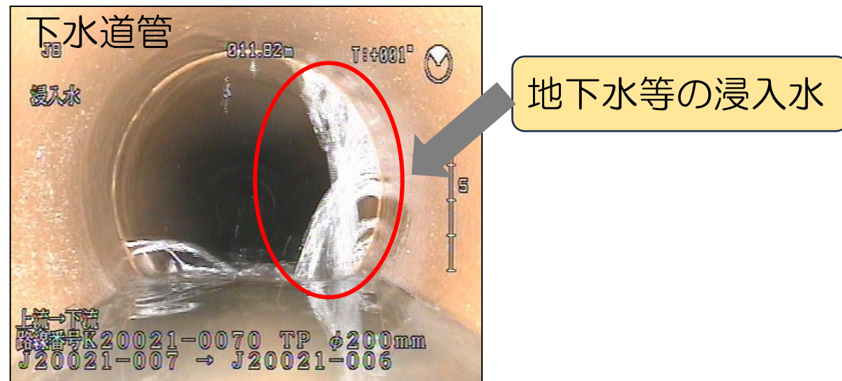
下水道管調査で発見された浸入水の状況
