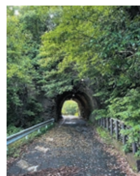
城下トンネル
