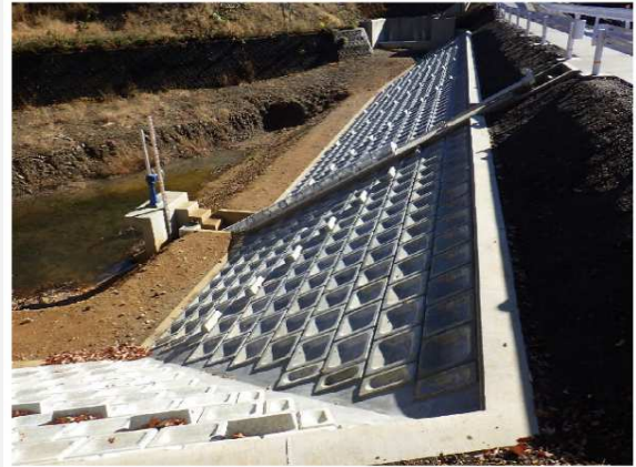
改修後のため池
