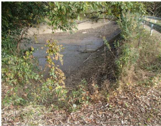
改修前のため池
