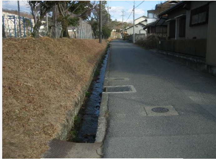
城東小学校南側道路排水路
