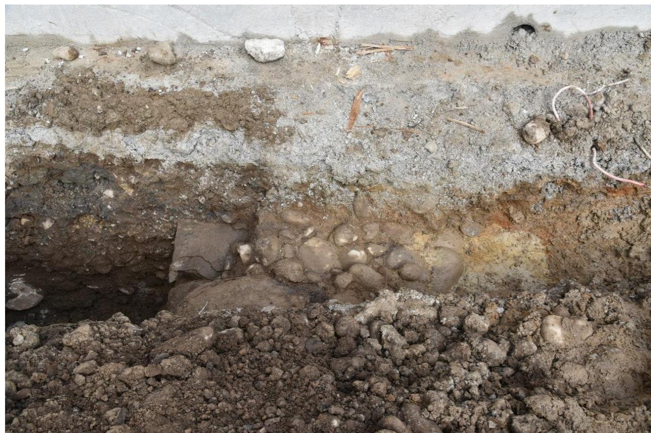
試掘トレンチ石垣検出状況（南から）
