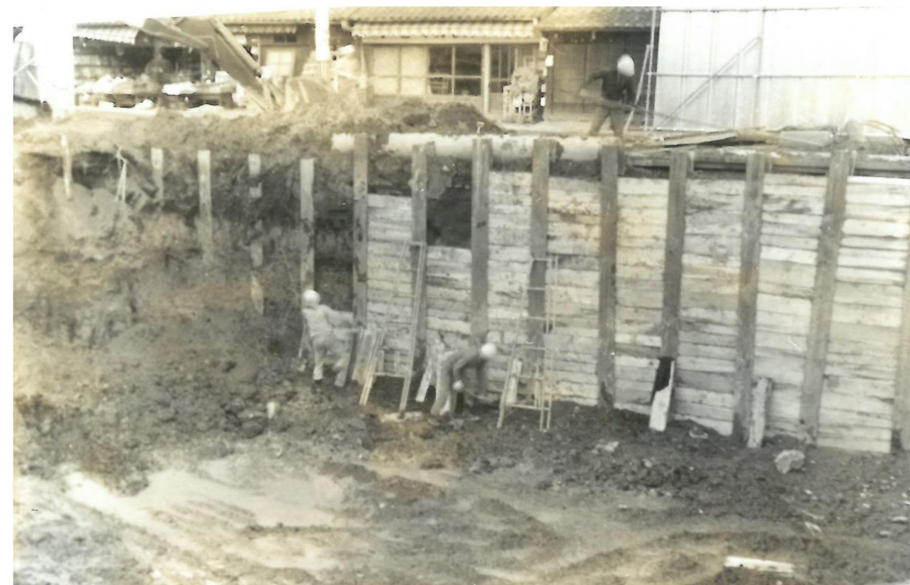
矢板設置状況（南西又は北西から）
