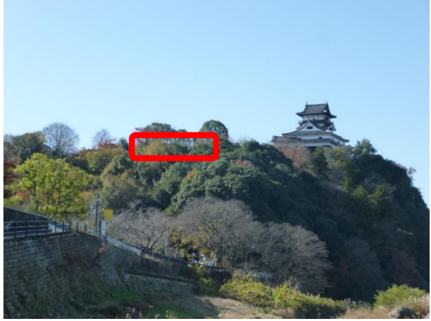
天守東側伐採箇所
