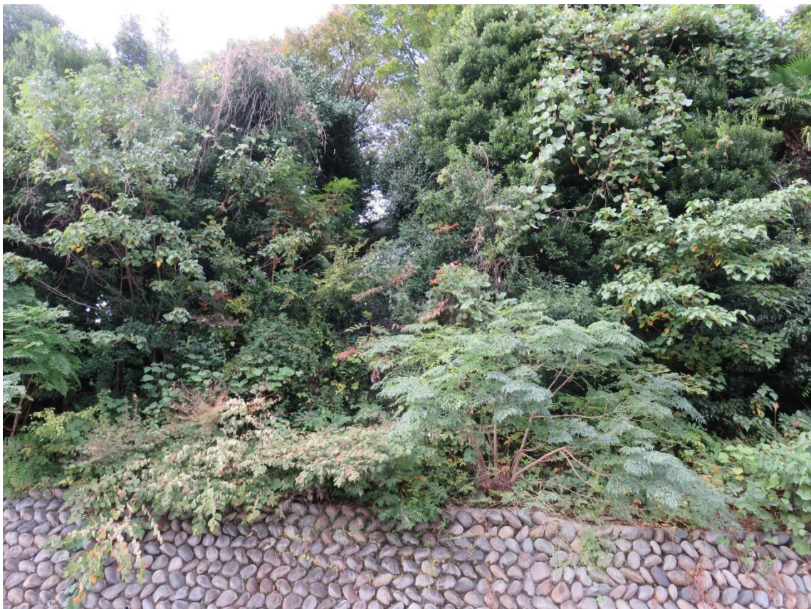
⑥ ネット設置後施工箇所全景（南から）
