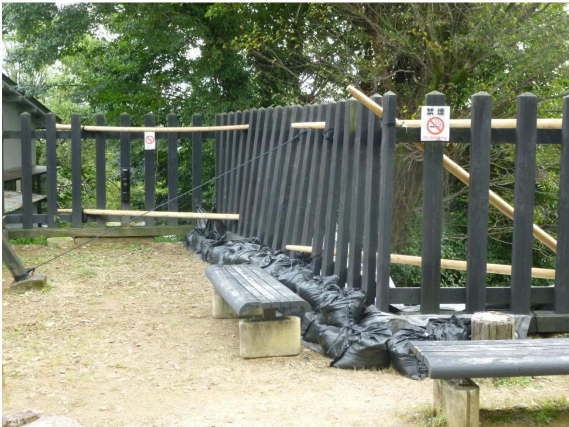
シート・土嚢設置状況（石垣上部）
