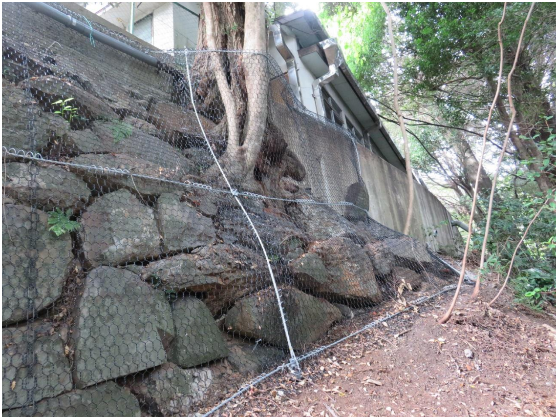
①No. 509 石垣 ネット設置状況（南東から）
