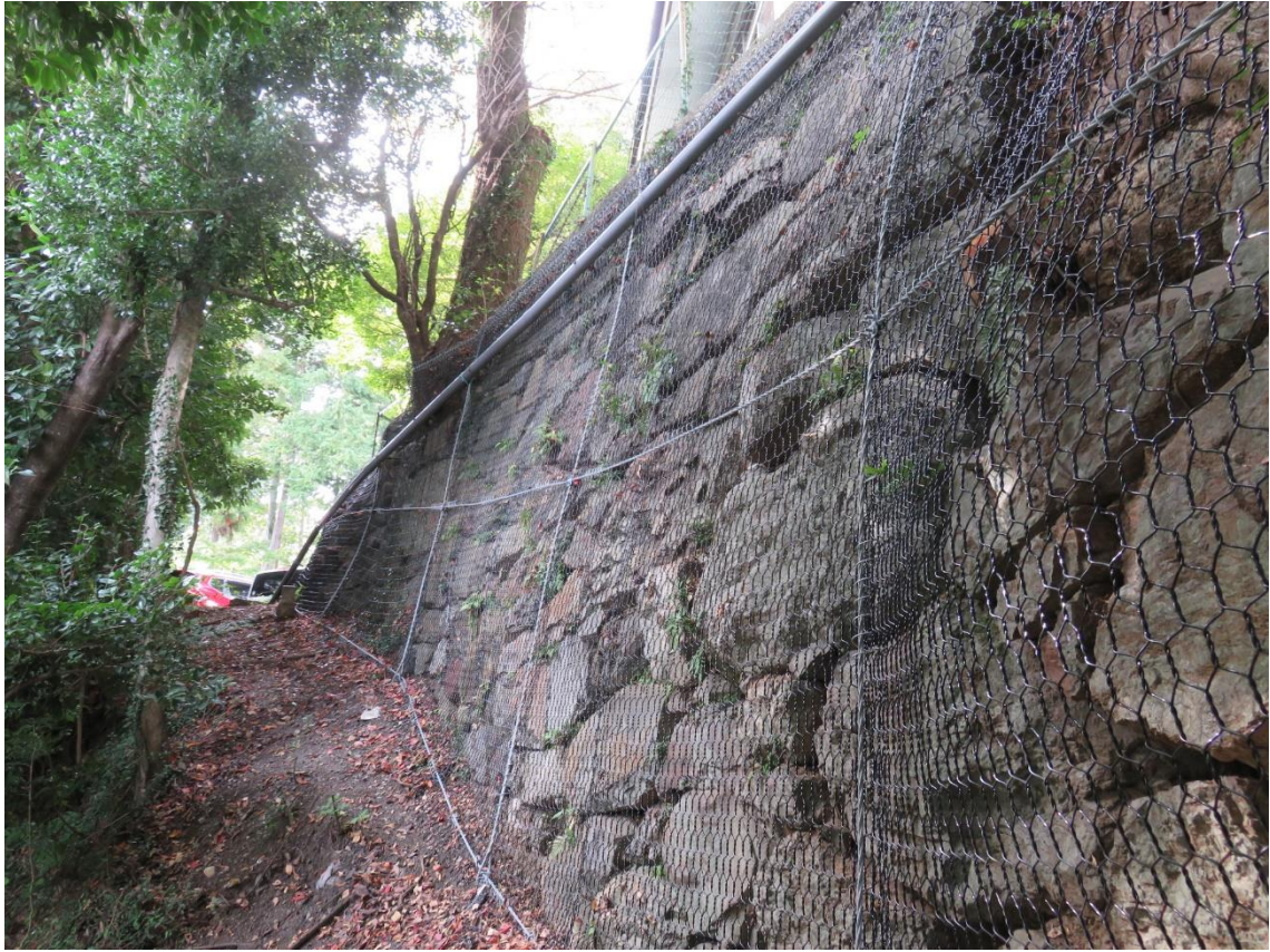
③No. 510 石垣 ネット設置状況 (南東から)
