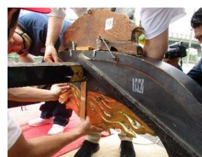
下本町鬼板・懸魚・破風（施工打合せ）
