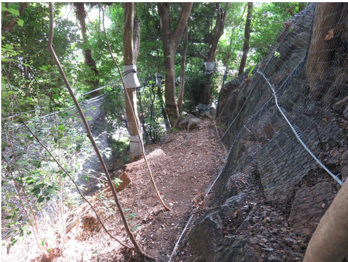
②No. 509 石垣 ネット設置状況（北から）
