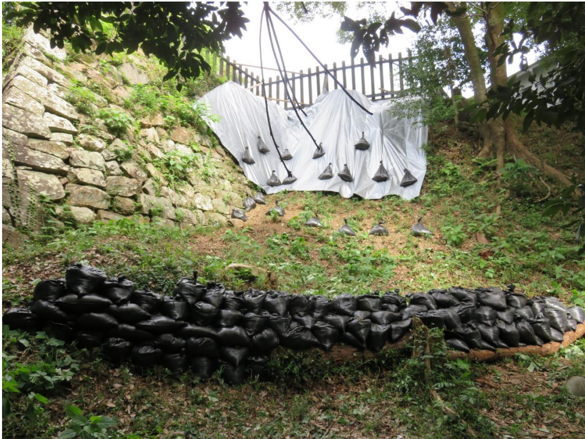
シート・土嚢設置状況
