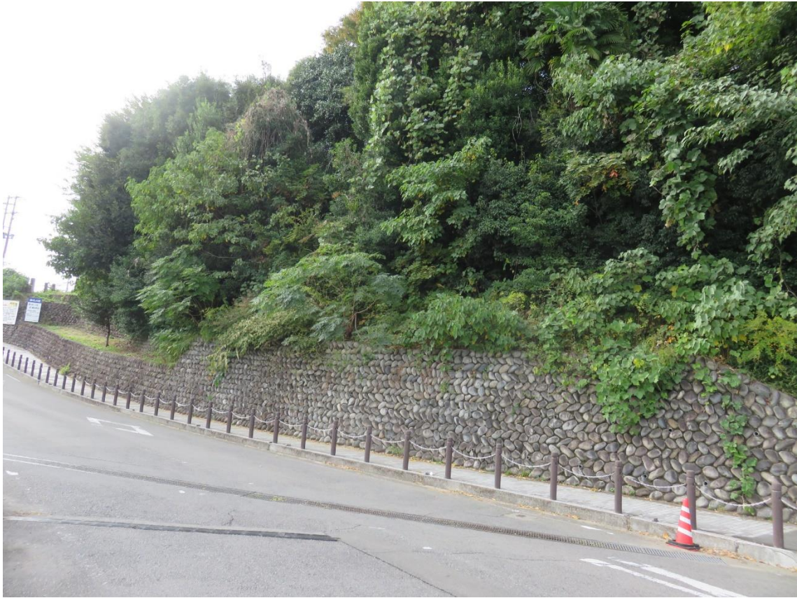
⑤ ネット設置後施工箇所全景（東から）
