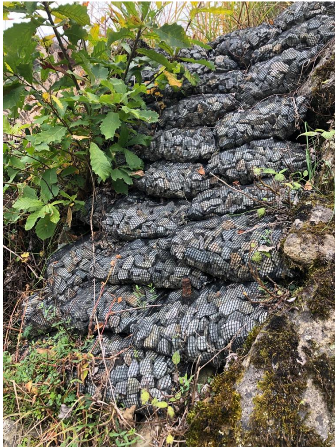
碎石土嚢設置状況
