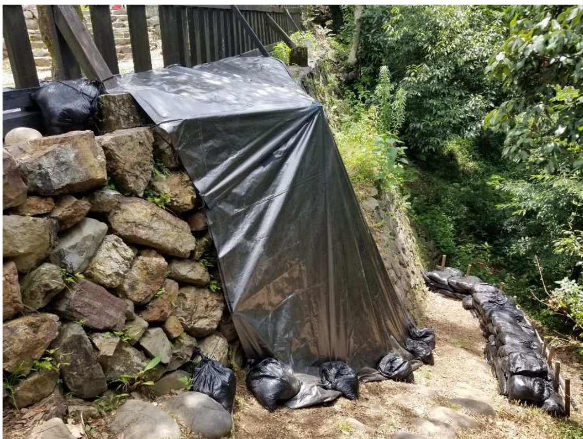
ビニールシート設置状況（石垣面）
