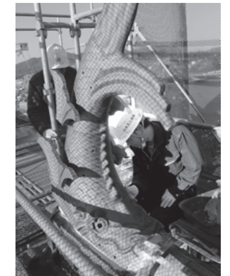
▲2月26日に取り付け工事が行われた新しい鯨瓦
