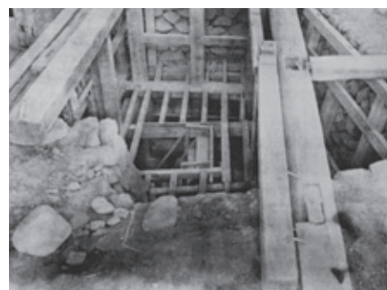
▲昭和36年から40年にかけて実施された解体修理。天守は完全に解体され土台が見えている。（昭和40年8月31日刊行「国宝犬山城天守修理工事報告書」より）
