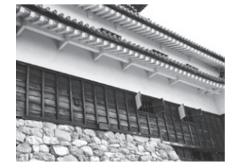
▲風雨で色落ちした外部腰板。墨塗りを行う。
