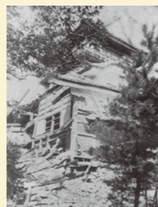
明治24年の破損状況
