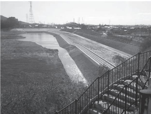
防災ダム事業（新池）
