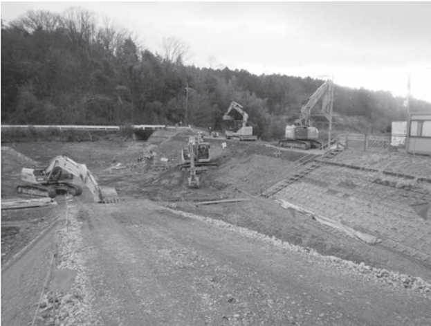
防災ダム事業（虎熊大池）工事中
