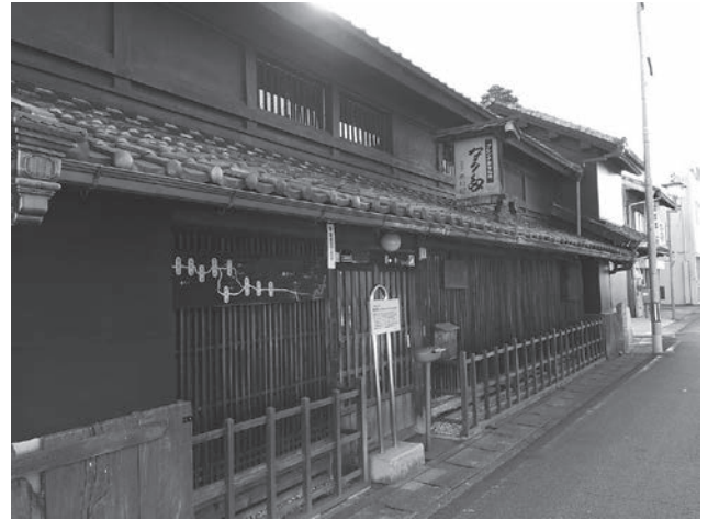
修理事業を実施し活用された事例 (奥村家住宅)
