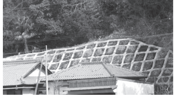
治山工事（今井）
