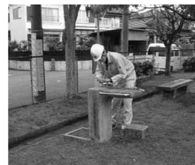
日の出南公園 今井設備工業株式会社による点検
