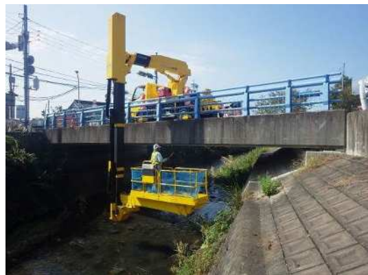
写真-1.3 専門業者による点検状況②
