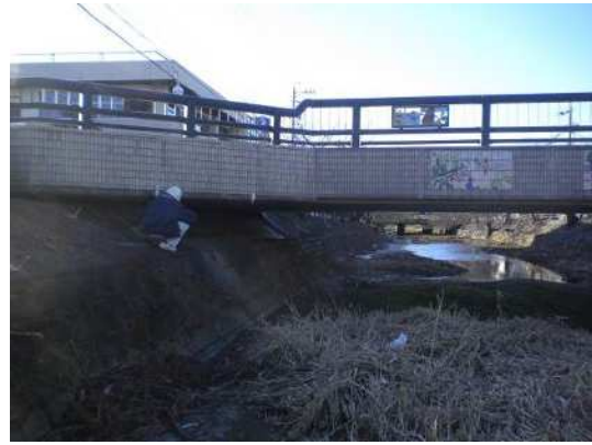
写真-1.5 職員による点検状況②
