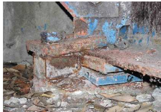
写真-4.4 支承部の損傷状況（支承部の機能障害）
