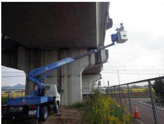
写真-1.2 専門業者による点検状況①
