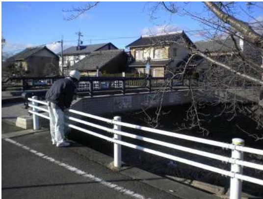
写真-1.4 職員による点検状況①
