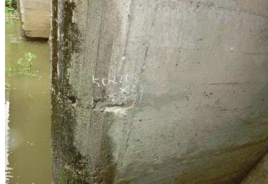
写真-4.3 下部工の損傷状況（剥離・鉄筋露出）
