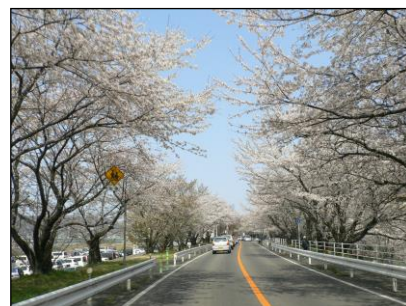
木曽川の堤防（御囲い堤）
